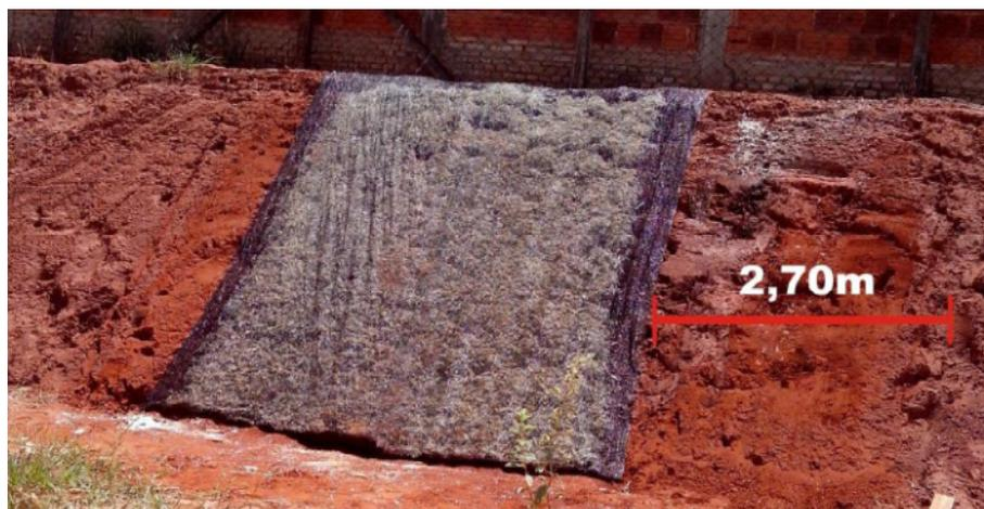
Figura 5. Proteção da biomanta ao talude.
