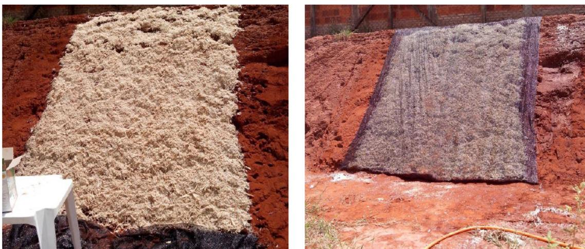
Figura 3. Instalação da biomanta de fibra do bagaço de cana de açúcar no talude.
